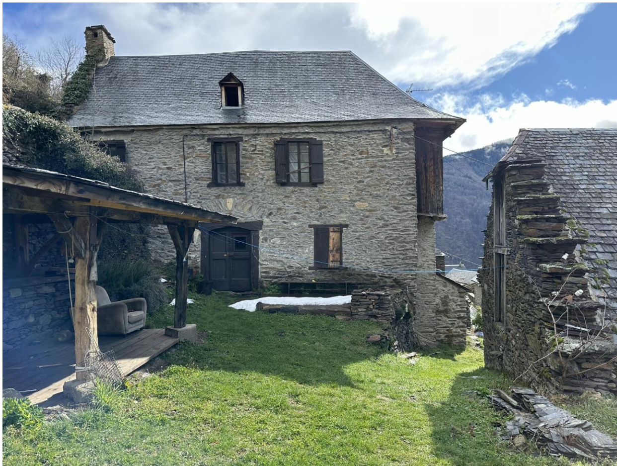
Img 01 – Fachada Oeste
